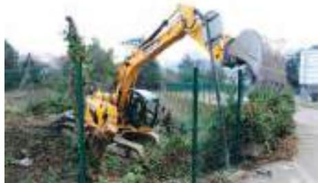
Il s'agit dans un premier temps de dégager le terrain de la végétation qui l'a envahi au fil des années pour, dans un deuxième temps, démolir les vieilles constructions pour permettre la poursuite du chantier.
